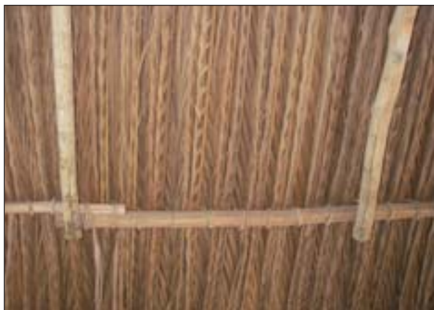
Cubierta del tejado de hoja de manaca (Foto: C. de Jong)
