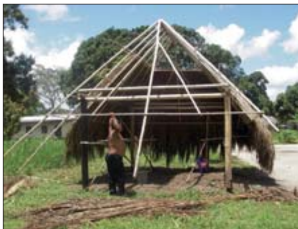
Construcción de una cabaña nueva (Erowarte) (Foto: C. de Jong)
